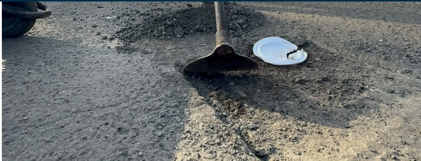
Recuperação do asfalto. (Léo de França, Midiamax)
