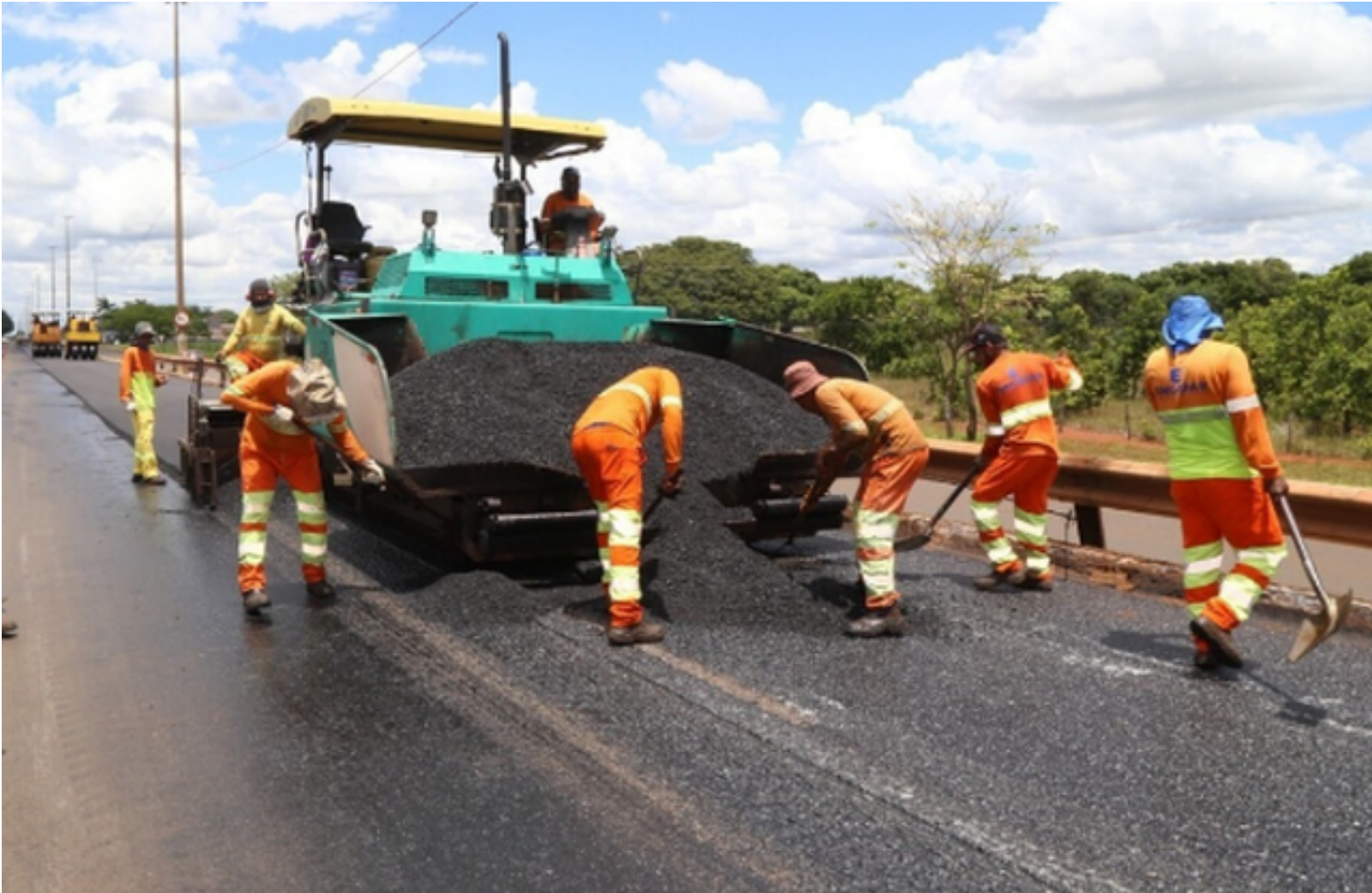
quipe de trabalhadores executando obra de implementação de asfalto (Foto: arquivo)
