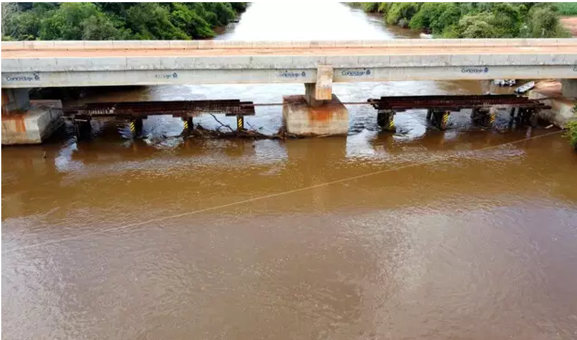
Ponte de concreto na MS-274, entre Dourados e Deodópolis, inaugurada em 2023. (Foto: Governo de MS)
