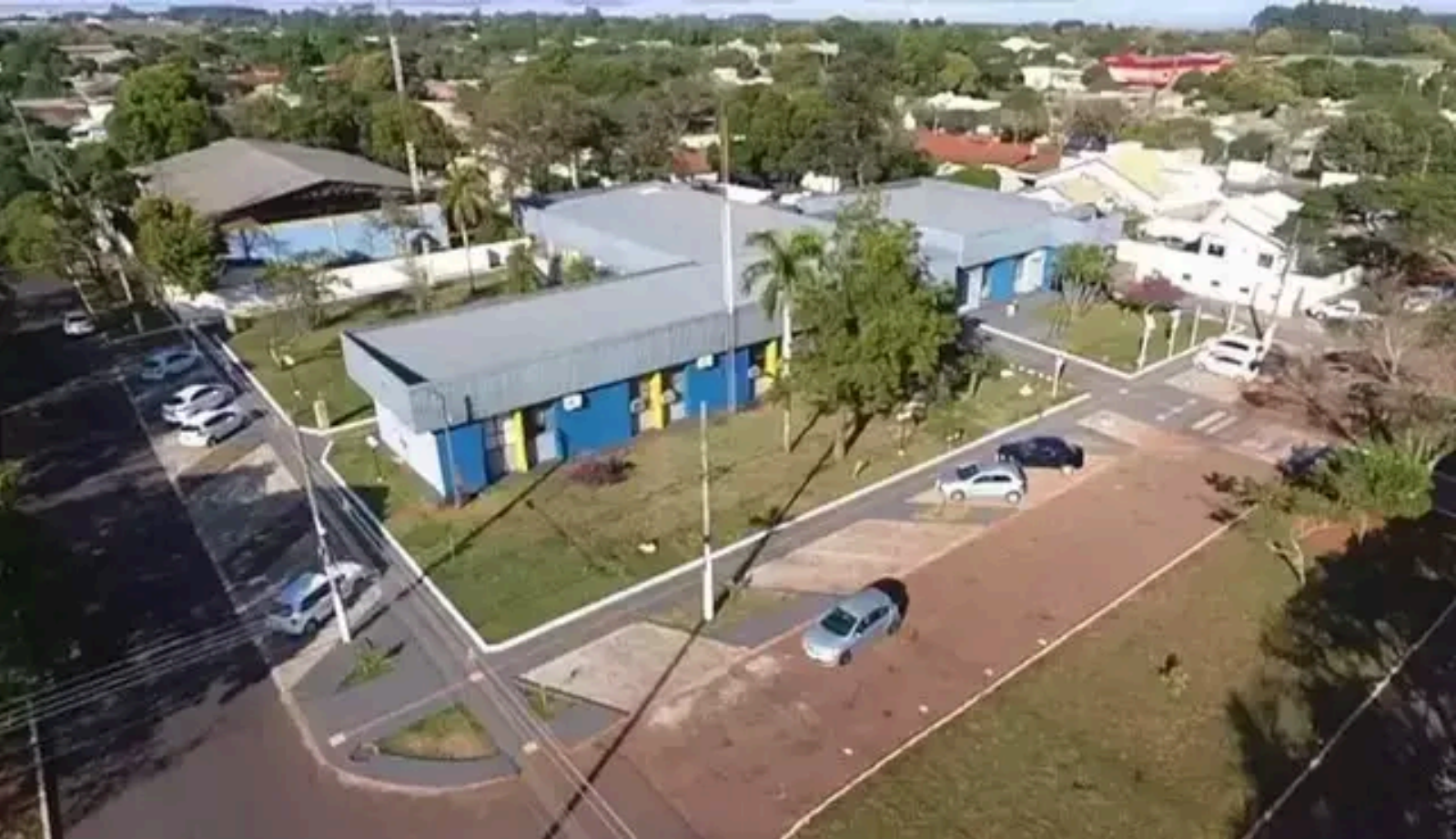
Prédio da Prefeitura de Iguatemi, município que fica ao sul de Mato Grosso do Sul (Foto: Divulgação/Arquivo)
